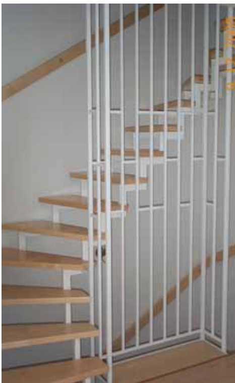
Abbildung: 2-Holm Treppe 2 x ¼ gewandelt Belag Stufen: Buche Geländer: Harfe
