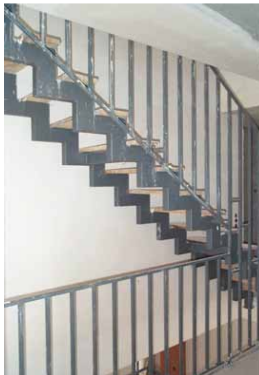
Abbildung: Im Bau befindliche Systemtreppe
