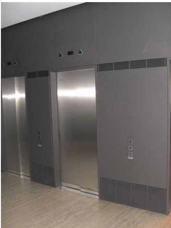
Nach der Sanierung durch Meccano GmbH
